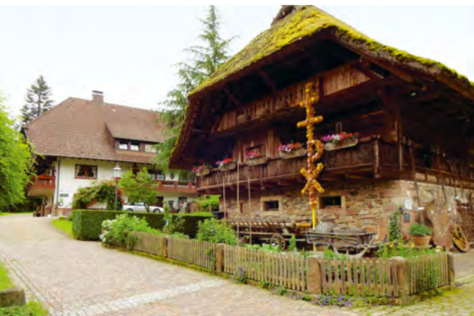
Bewahrung regionaler Baukultur in Oberharmersbach
