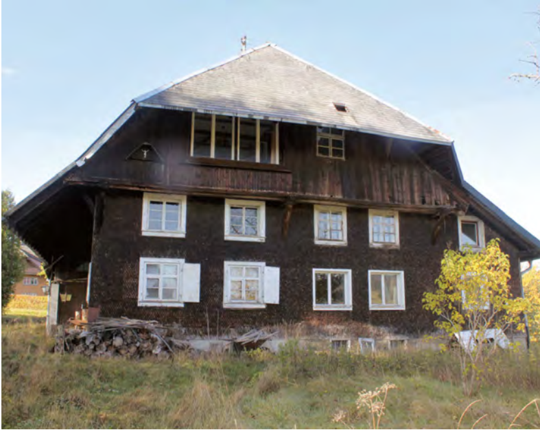
Aufgegebener sanierungsbedürftiger Schwarzwaldbauernhof in Bernau im Schwarzwald
